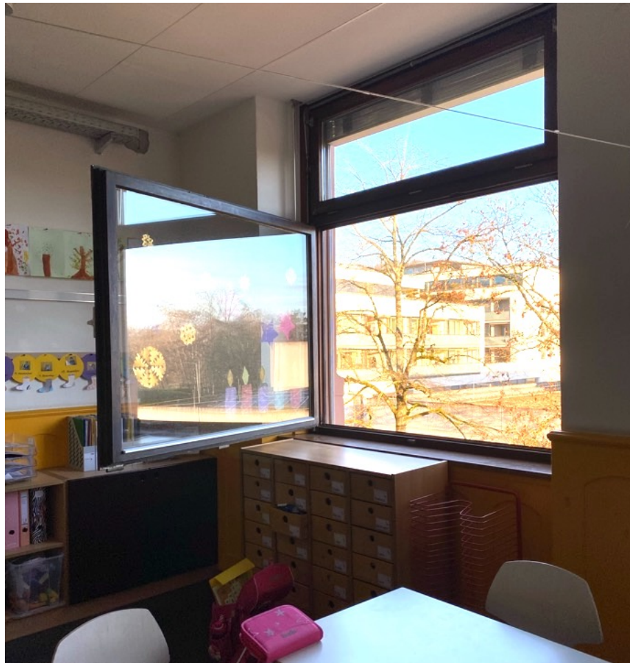
Raumverlust bei geöffnetem Fenster
