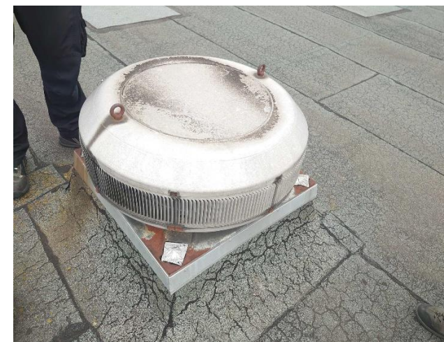
Provisorisch instandgehaltene Verwahrungen der Hallenlüftung
